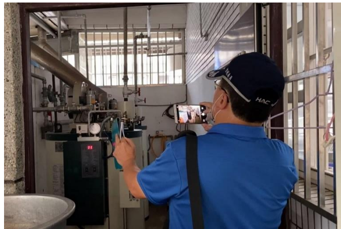
檢查鍋爐管線開關
