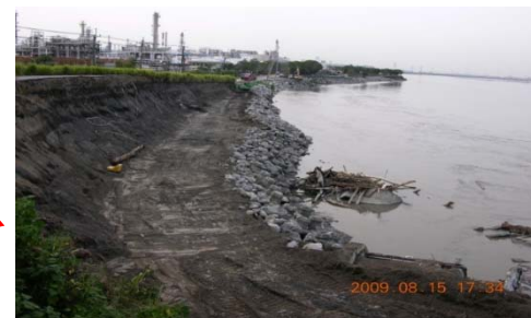
高屏溪堤防搶險
