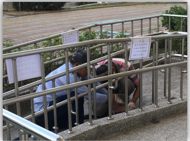
無障礙坡道扶手修繕
