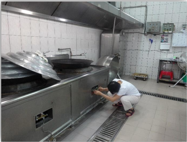
廚房鍋爐管線測試
