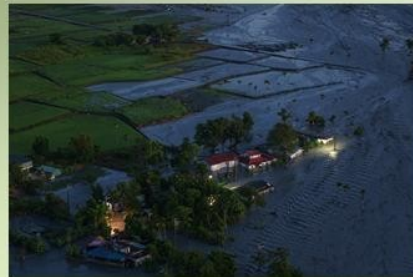
花蓮縣太魯閣溪上游堰塞湖 於2025年9月23日發生溢流潰壩，導致下游的花蓮鄉等處淹水、道路阻斷、橋樑沖毀、人民傷亡等重大災情。 (攝影／謝佩璇)
