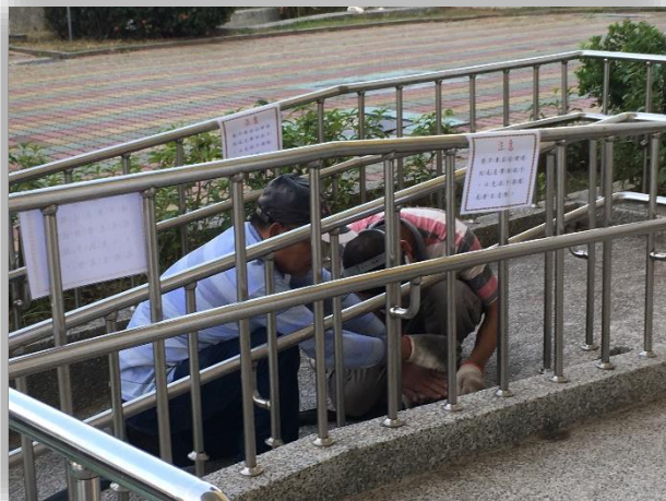
無障礙坡道扶手修繕
