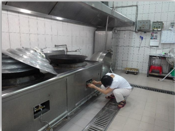
廚房鍋爐管線測試
